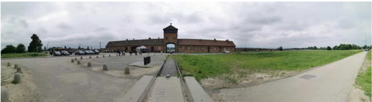
Der bekannte Blick auf das Eingangstor von Auschwitz-Birkenau (2025): Als Panorama-Bild. Dieser Nahbereich ist von Bewuchs frei gehalten. Immerhin.
